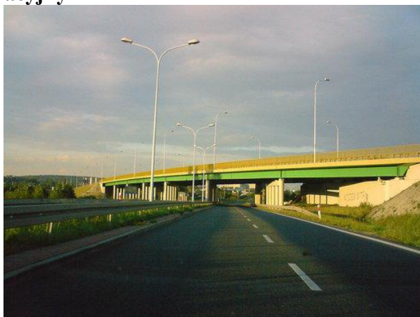
Obwodnica Skarżyska-Kamiennej – droga krajowa nr 7
